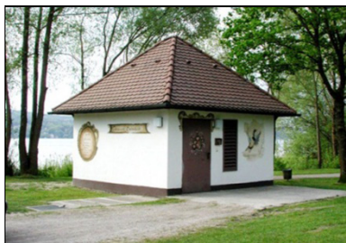
Traditionelle Bauwerke mit modernster Technik
