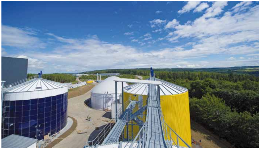
Blick über die größte Bio-Erdgasanlage in Rheinland-Pfalz, die die EVM derzeit bei Boppard errichtet.
